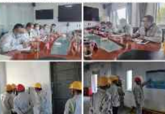
宁夏中宁风电项目、石嘴山光伏项目配合开展国投电力安全生产交叉互检工作。
