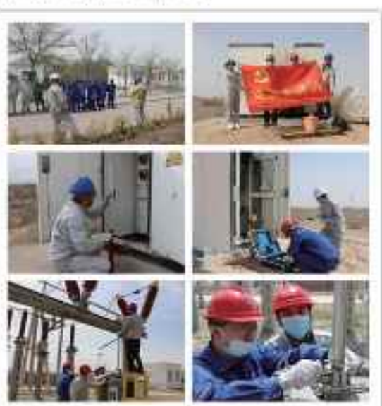
甘肃捡财塘风电项目检修现场。
